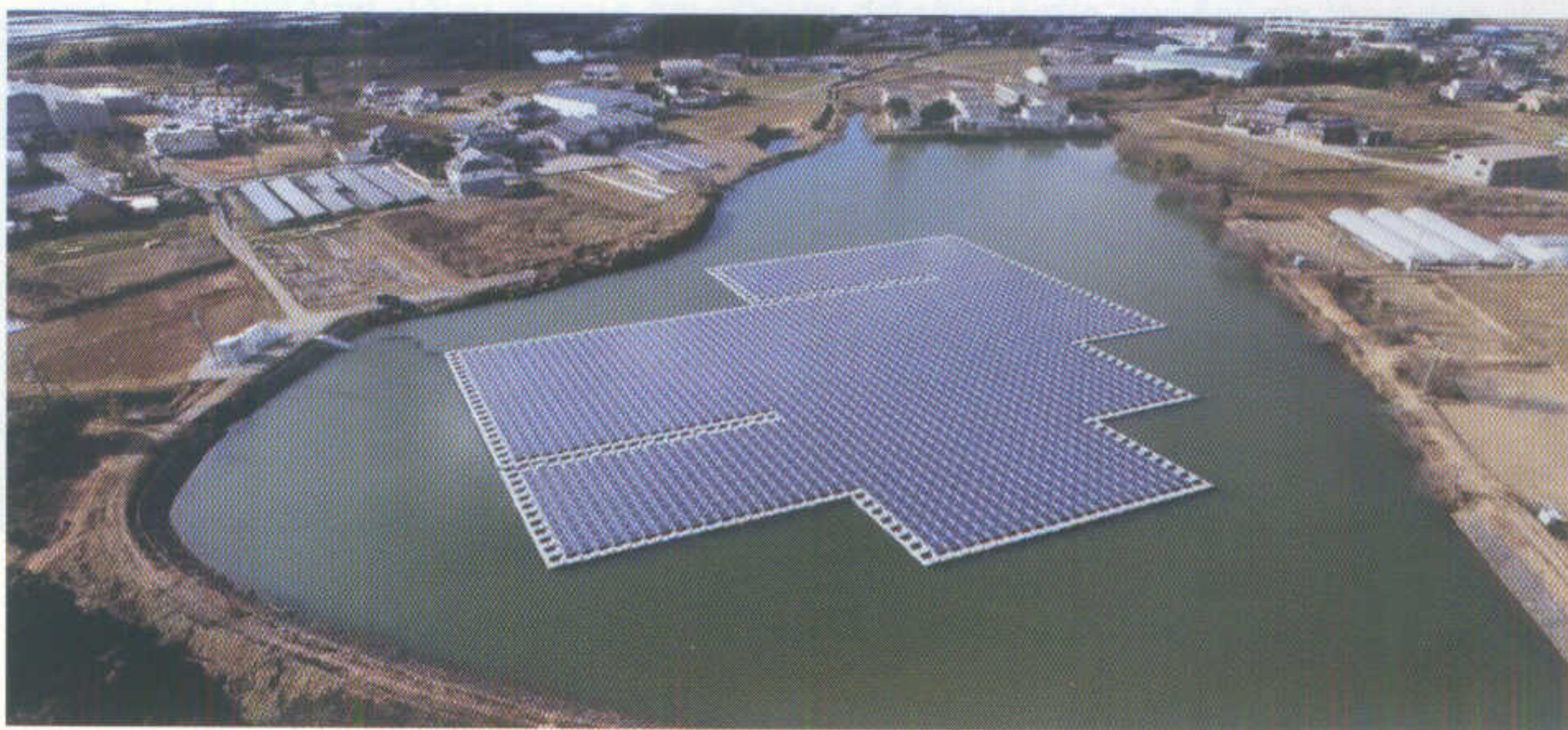
Slika 6.8. Plivajuća fotonaponska elektrana u Japanu, čija je instalisana snaga 572 kW
